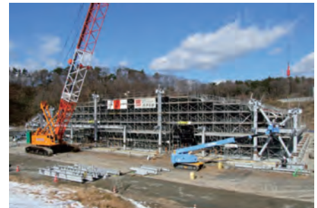
■ 写真7-(2)-1 災害時拠点施設の建設工事(21世紀の森公園) [平成28(2016)年2月 いわき市撮影]
