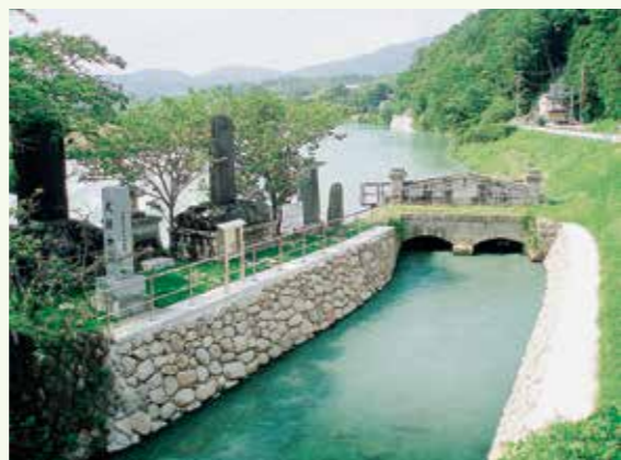
取水口(小川町関場)
