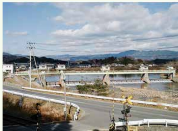
愛谷頭首工(赤井字大作場)
