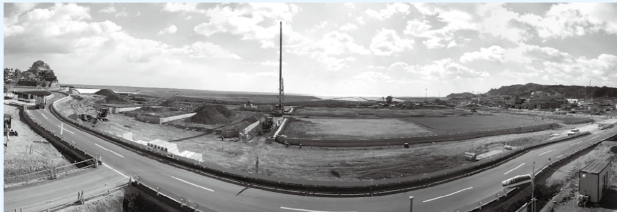
久之浜地区の工事箇所【2月撮影】
