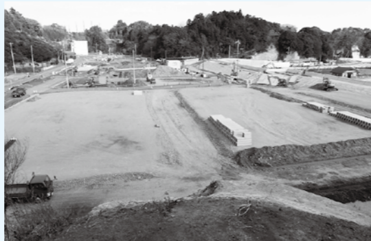
小浜地区の工事箇所【2月撮影】
