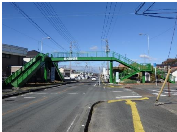
写真 原木田歩道橋
