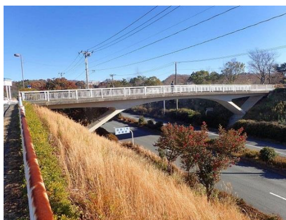
写真 飯野 1 号歩道橋
