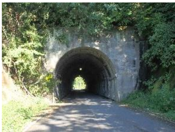
写真 三沢トンネル
