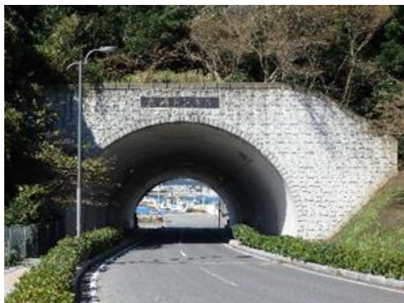
写真 三崎トンネル
