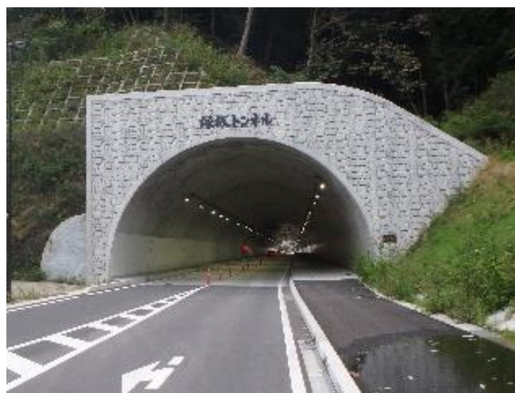
写真 堀坂トンネル
