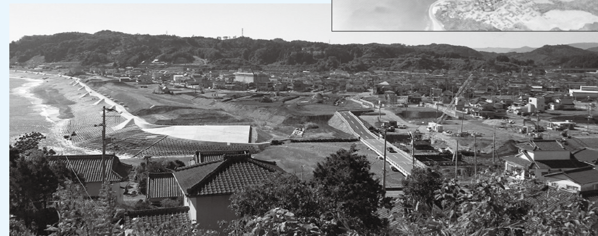
久之浜市街地工区では宅地造成が完了し、宅地擁壁や道路・水路等の公共施設、ライフラインなどの整備が進む(宅地引き渡し時期：来年3月ごろ～H29年10月ごろ)【本年11月撮影】
