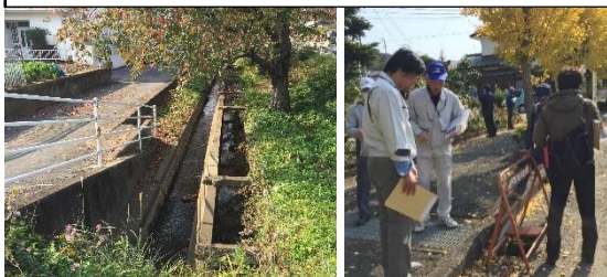
水路等が集中し水が溢れやすい箇所
