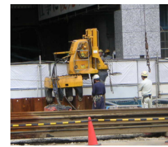
圧入によるシートパイル施工
