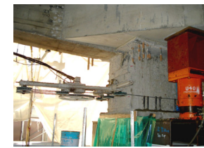
ワイヤーソーによる躯体切断
