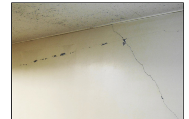
2 コア壁のひび割れ
