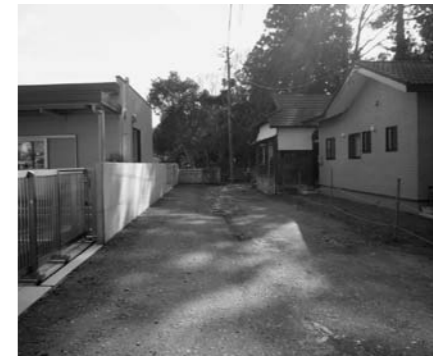
復興道路整備事業で改良を行う錦町の御宝殿3号線外1線
