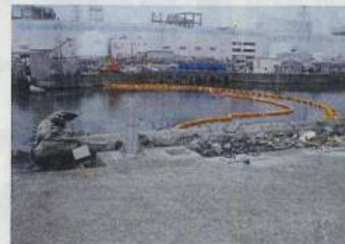
シルトフェンス設置
