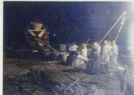
凝固剤注入による止水対策
