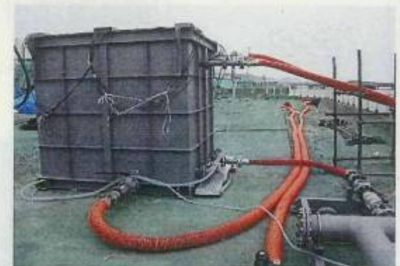
海水循環型浄化装置設置
