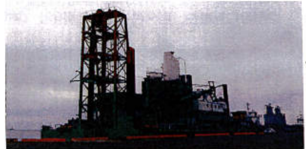
写真-1 作業船団（小名浜港にて撮影）
