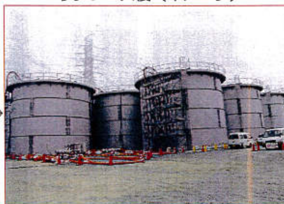
1,000トンの地上大型鋼製丸形タンク×30基 合計容量：30,000トン
