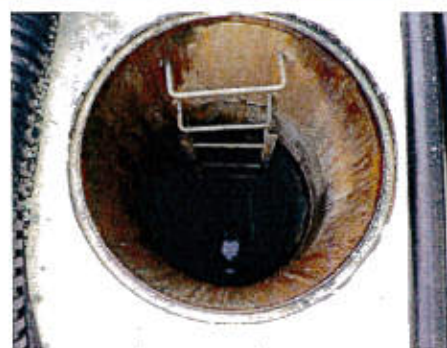
サブドレンピット内部
