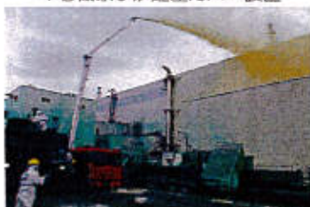
敷地、建屋本体への飛散防止剤散布
