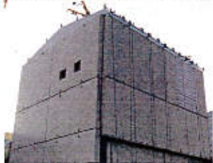
1号機原子炉建屋カバー設置
