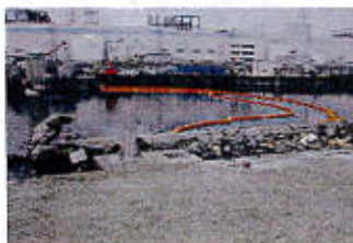
シルトフェンス設置
