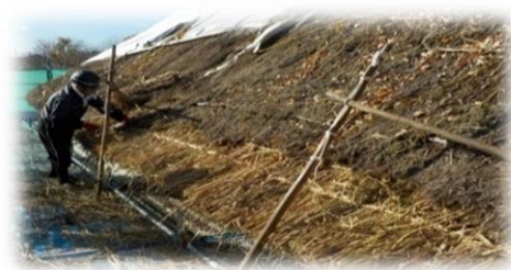
茅葺屋根改修工事の様子
