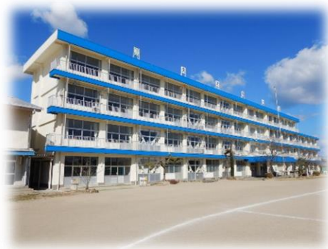
外壁等改修工事後の校舎
