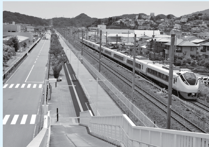
〈写真2〉跨線橋から望む現在の街並み（平成27年7月いわき市撮影）
