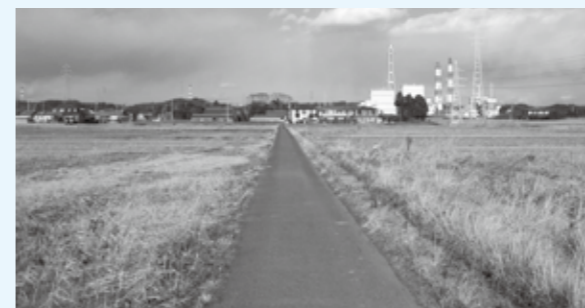
整備前の状況(幅員2メートル)
