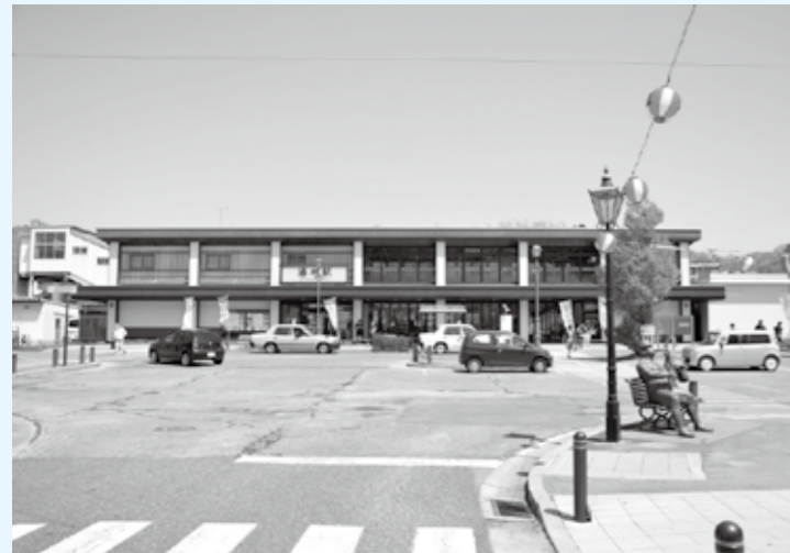
3月にリニューアルオープンとなった現在の湯本駅舎
