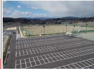
新舞子多目的運動場駐車場全景(H28年4月)
