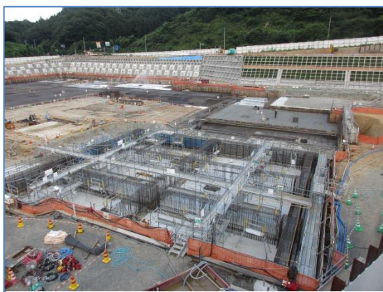
◆建設工事が進む新病院
