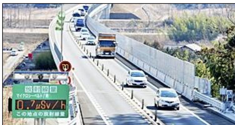
【全線開通した「常磐自動車道」】
