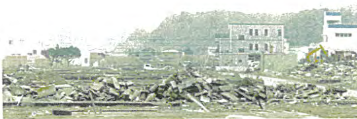
薄磯地区被災状況
