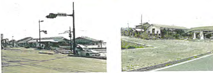
四倉地区被災状況
