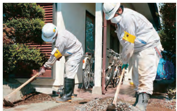
■ 写真6-(4)-4 除染の実施状況 [平成26(2014)年9月 いわき市撮影]
