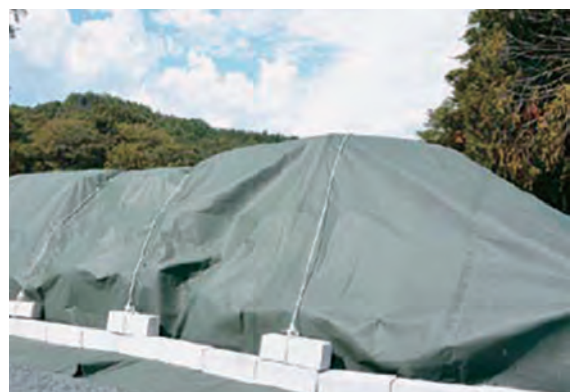
■写真6-(4)-5 仮置場の状況
