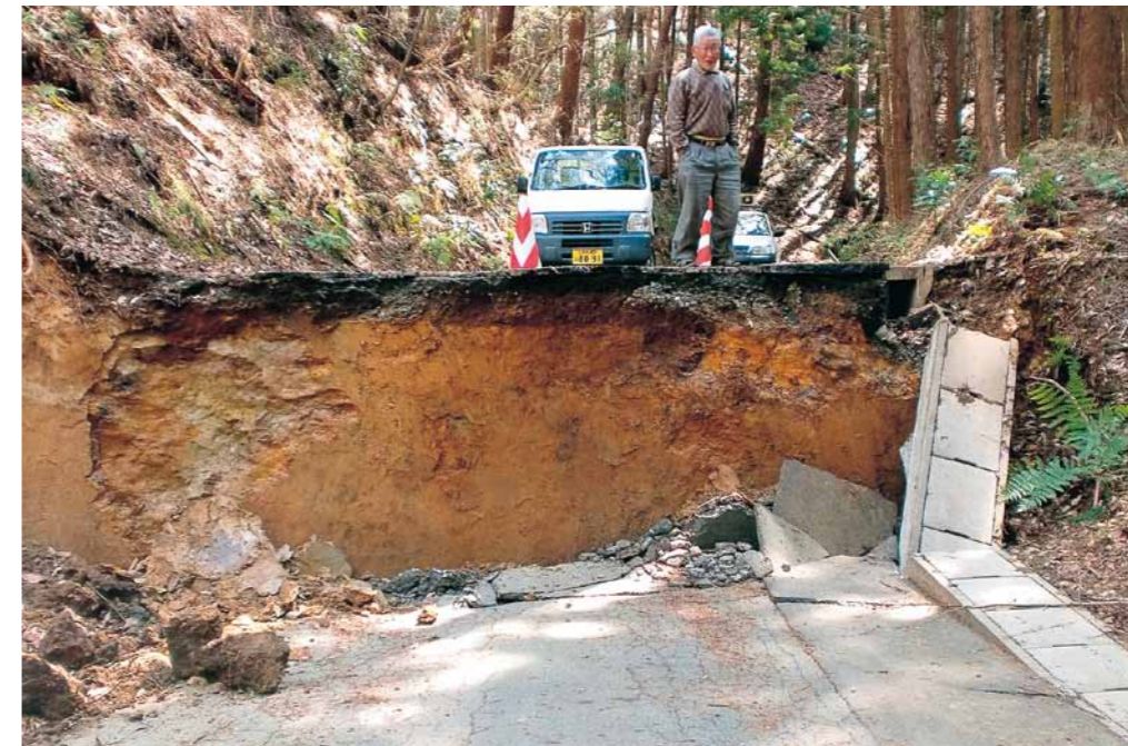
田人町には複数の断層が走っている。4月の余震で2mほどの段差ができた道路が何カ所も発生 (4月13日)
