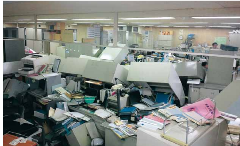
震度6弱の烈震で書棚などが倒れるなど、大きく被災したいわき市役所本庁舎。災害対策本部は、消防本部に置かざるを得ない事態に陥った (3月11日14:55ごろ)
