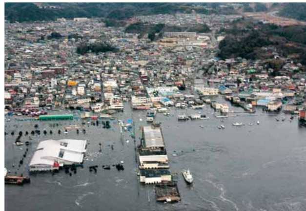
津波で孤立した「いわき・ら・ら・ミュウ」。施設は、11月25日に再オープンした (3月11日15:50ごろ 県消防防災航空隊提供)
