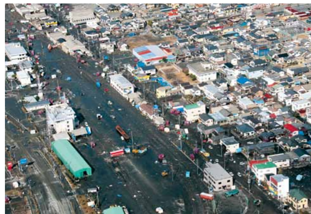
福島臨海鉄道小名浜駅貨物ヤード。コンテナなどが散乱している (3月12日 県消防防災航空隊提供)
