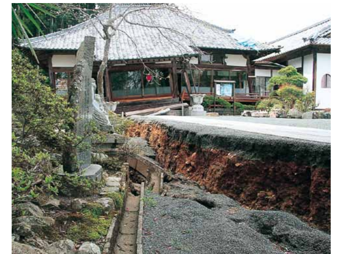
4月11・12日の震度6弱の直下型余震。断層が永い眠りから覚めてしまった。常磐藤原町の建徳寺境内の地割れ (5月2日 宍戸博氏提供)
