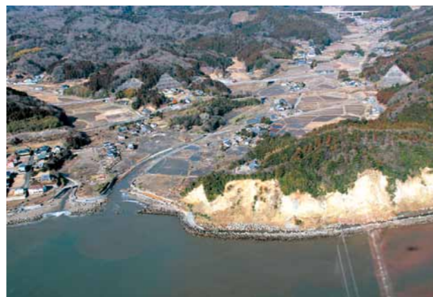
津波が襲った翌朝の久之浜町末続地区 (3月12日 県消防防災航空隊提供)
