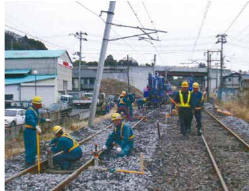
いわき駅～内郷駅の復旧作業(3月18日:JR東日本水戸支社提供)
