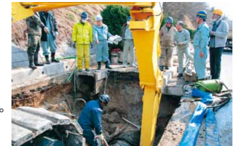
泉町下川地内の国道6号の水道管復旧工事(3月25日)
