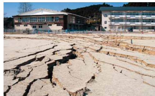
植田小の激しい校庭の地割れ(4月6日)
