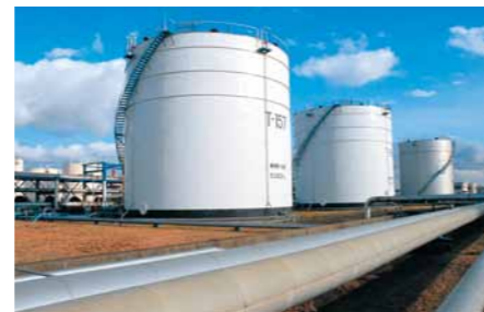
小名浜石油㈱ガソリン貯蔵タンク
