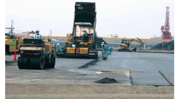
復旧が進む小名浜港5・6号ふ頭(7月25日)
