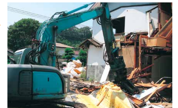
被災した家屋の解体撤去作業(7月15日)
