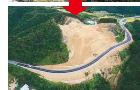
(上)4月11日、いわき石川線の渡辺町上釜戸地内で斜面が崩落 (下)仮設道路により8月31日に再開通 (県いわき建設事務所提供)
