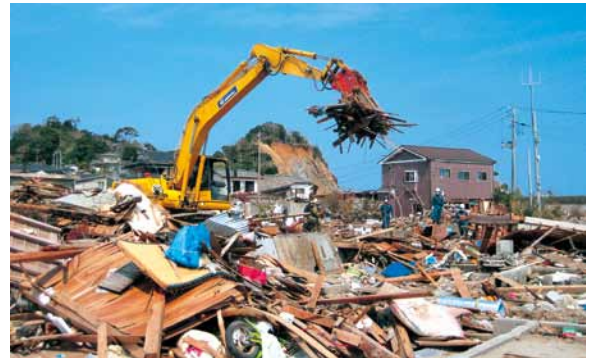
久之浜地区での重機による流出がれきの撤去作業(4月26日)
