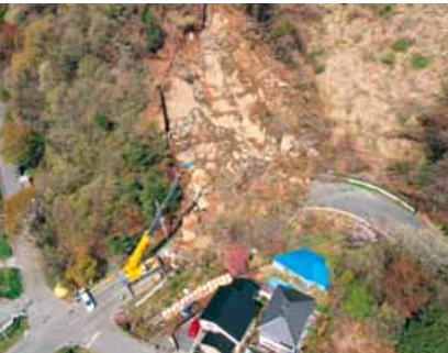
斜面が崩落し道路が完全にふさがれた内郷内町の市道宮沢・蛭内線(4月26日)
