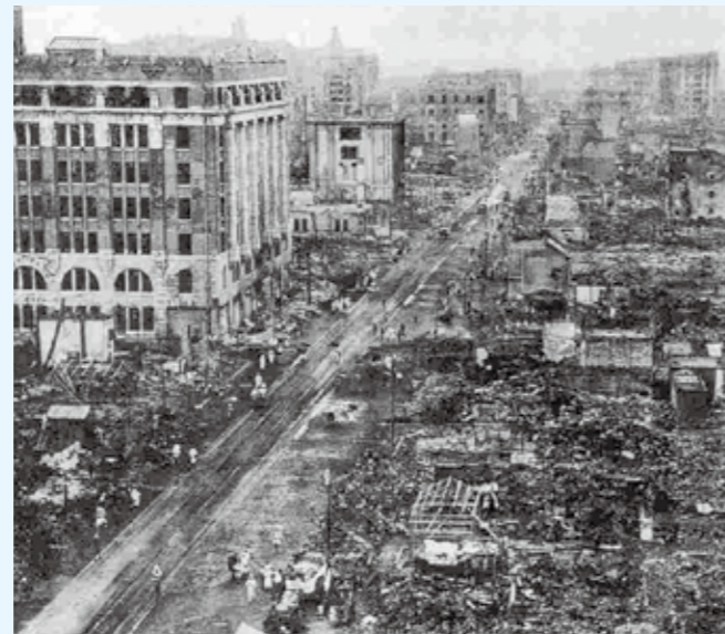
〈写真〉 関東大震災により壊滅的な被害を受けた東京・日本橋付近〔大正12（1922）年9月〕
