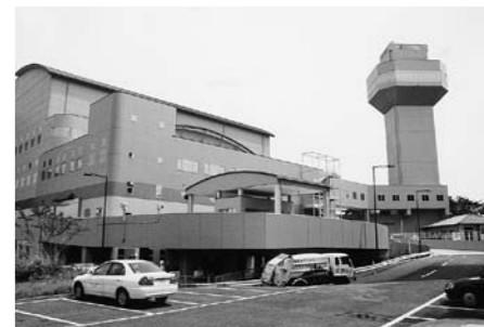
設備の改修を行う南部清掃センター
