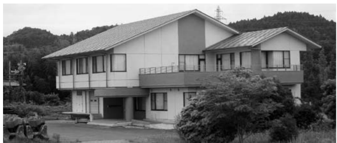
屋根等貸し事業の対象施設である夏井川河川防災センター
