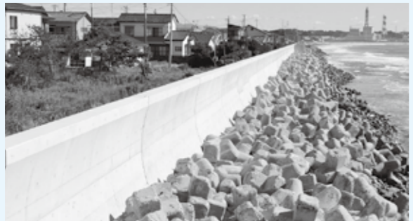
関田地区海岸堤防
