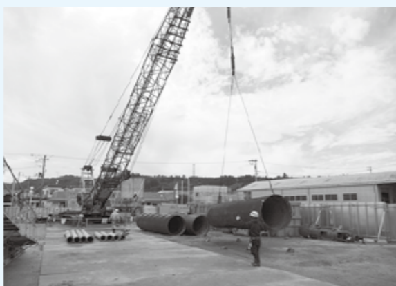
津波避難ビルの新築工事に着手(10月撮影)
