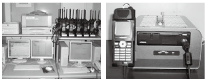
市移動系防災行政無線整備工事の一例（統制局【左】と移動局（半固定局）【右】）
