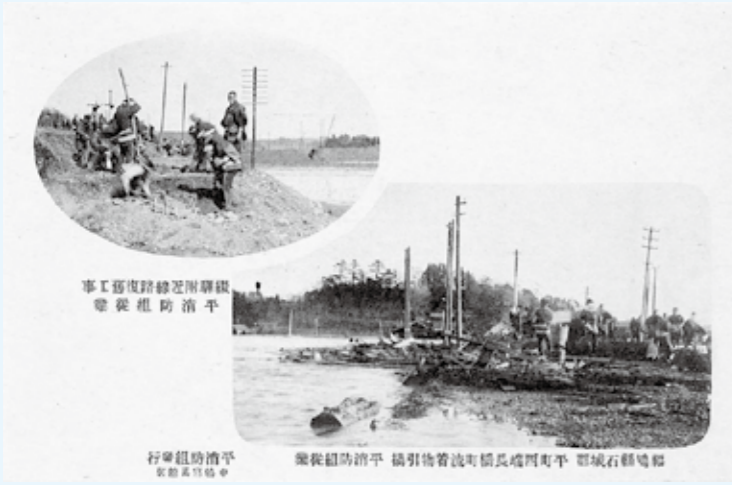
写真2 「石城郡水害惨状絵葉書（第1集）」綴（現内郷）駅付近の復旧／平町長橋町付近の漂流物引き揚げ
