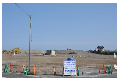
津波被災地の家屋基礎撤去工事（H25年5月）
