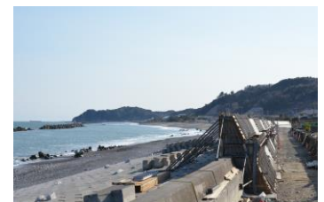
海岸堤防の整備工事 (H26年3月)
