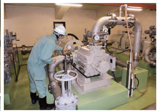
好間ポンプ場
