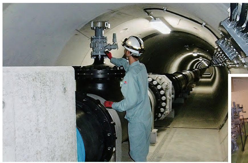
夏井川幹線管路トンネル
