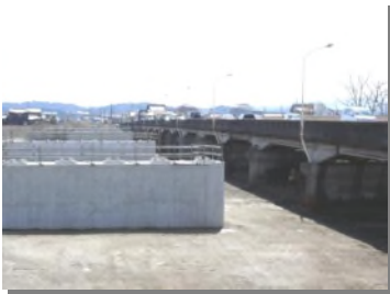
架け替えの進む鮫川橋
