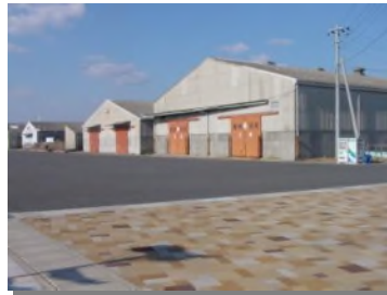
1, 2号埠頭倉庫群
