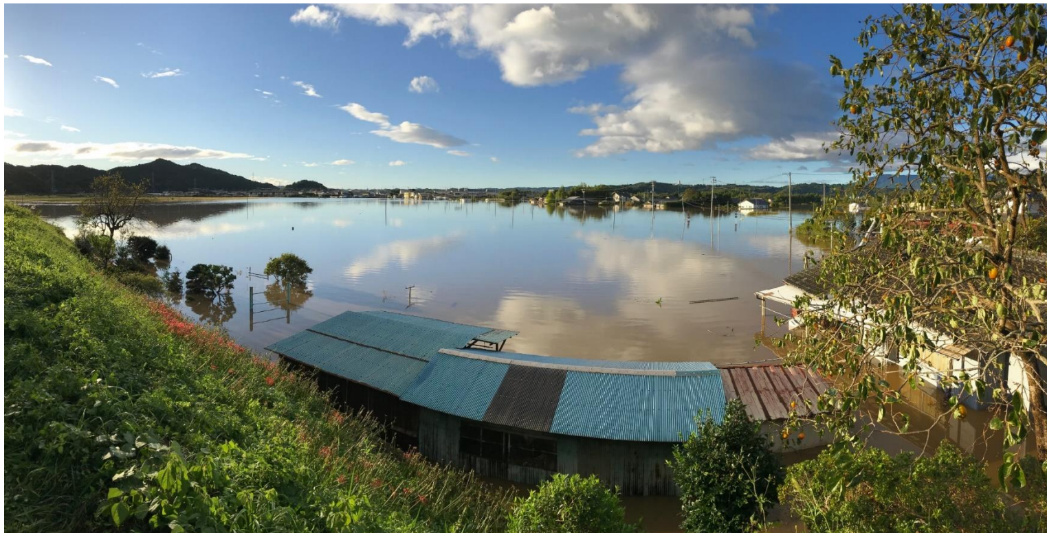
(写真:平窪地域の被害の様子)
