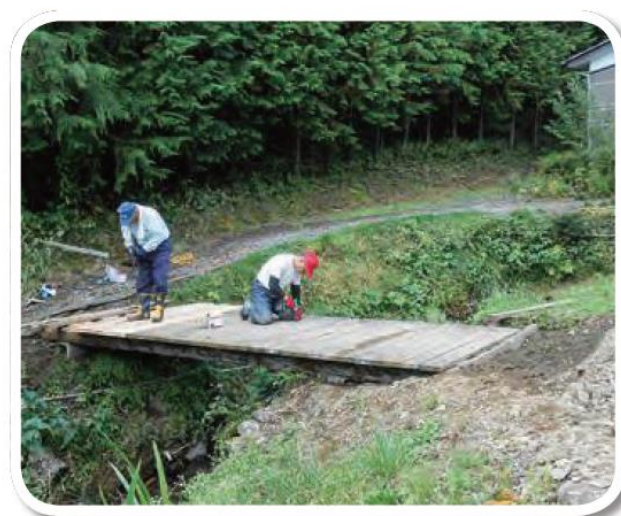
遠野地区：橋の復旧作業
