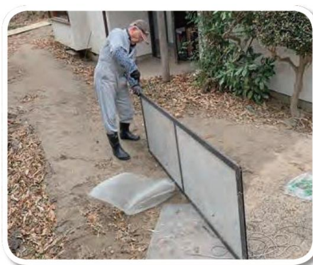
小川地区：網戸の解体作業
